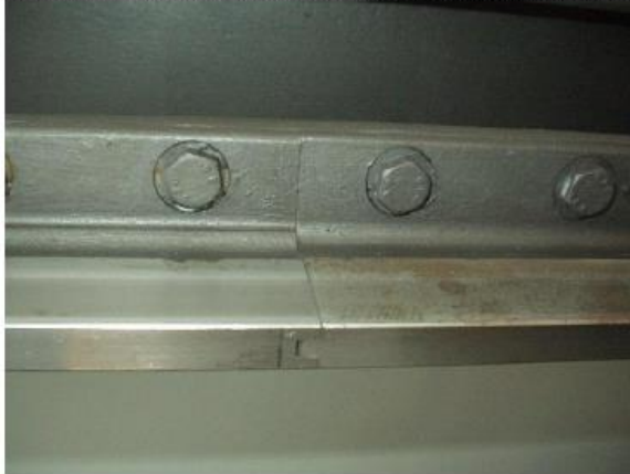
Vorhandene Schienenstöße am Gegengewicht waren nicht ordnungsgemäß verschliffen
