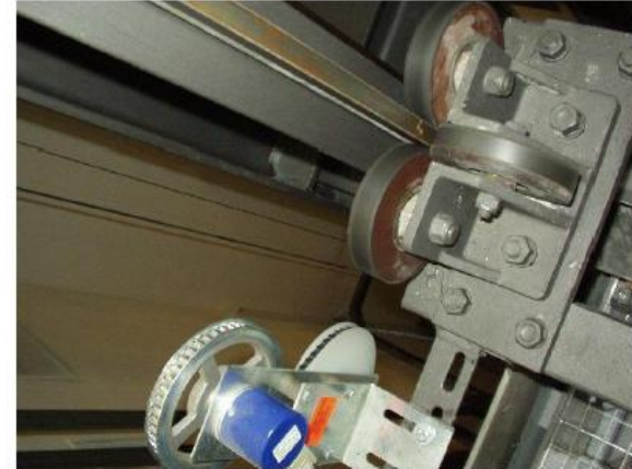
Starker Verschleiß des starr montierten 3-Rollen-Sets (Abrieb an der Mittel-Rolle)
