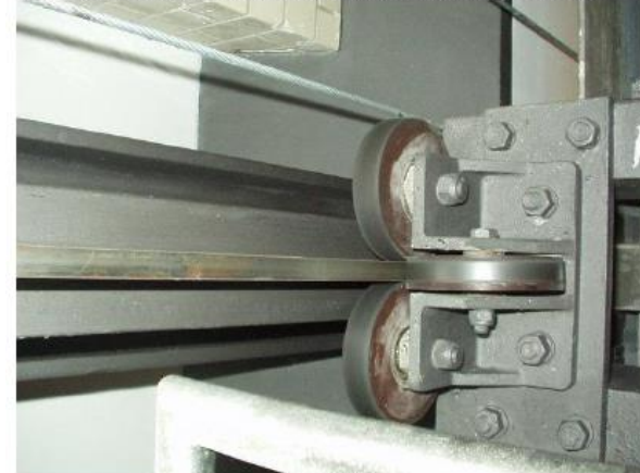
Starker Verschleiß des starr montierten 3-Rollen-Sets (Abrieb an der Mittel-Rolle)
