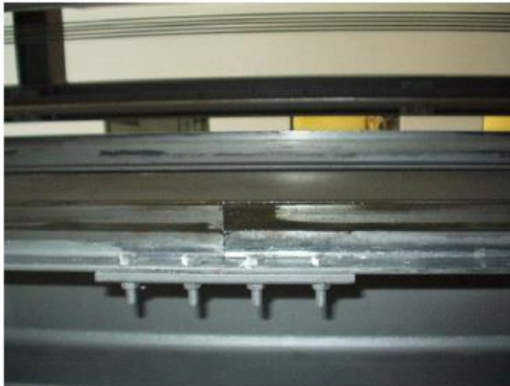
Vorhandene Schienenstöße am Gegengewicht waren nicht ordnungsgemäß verschliffen
